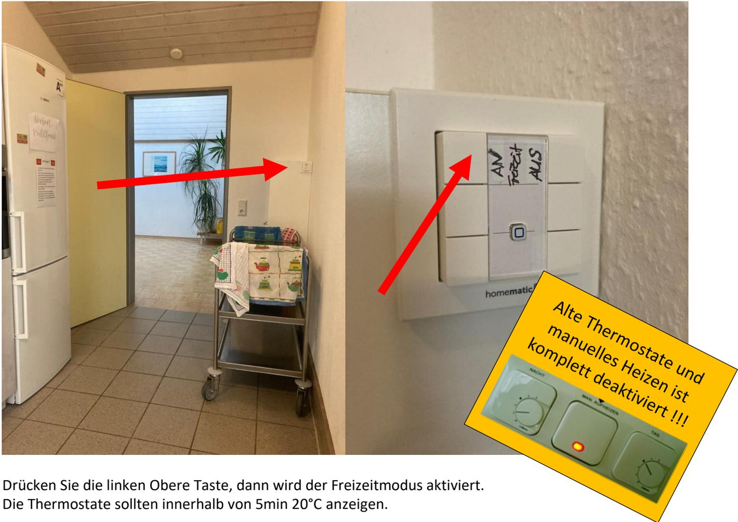
Drücken Sie die linken Obere Taste, dann wird der Freizeitmodus aktiviert. Die Thermostate sollten innerhalb von 5min 20°C anzeigen.
